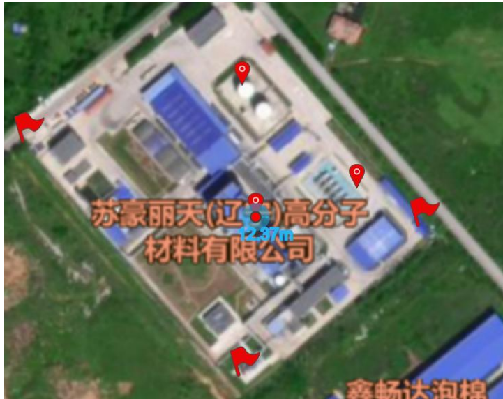
图 8-9 聚合反应釜大孔泄漏对压力容器的多米诺影响范围
