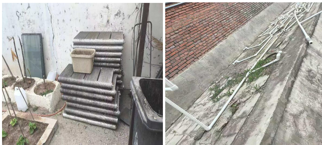
图3-10 锅炉供暖管道与暖气片拆除图
