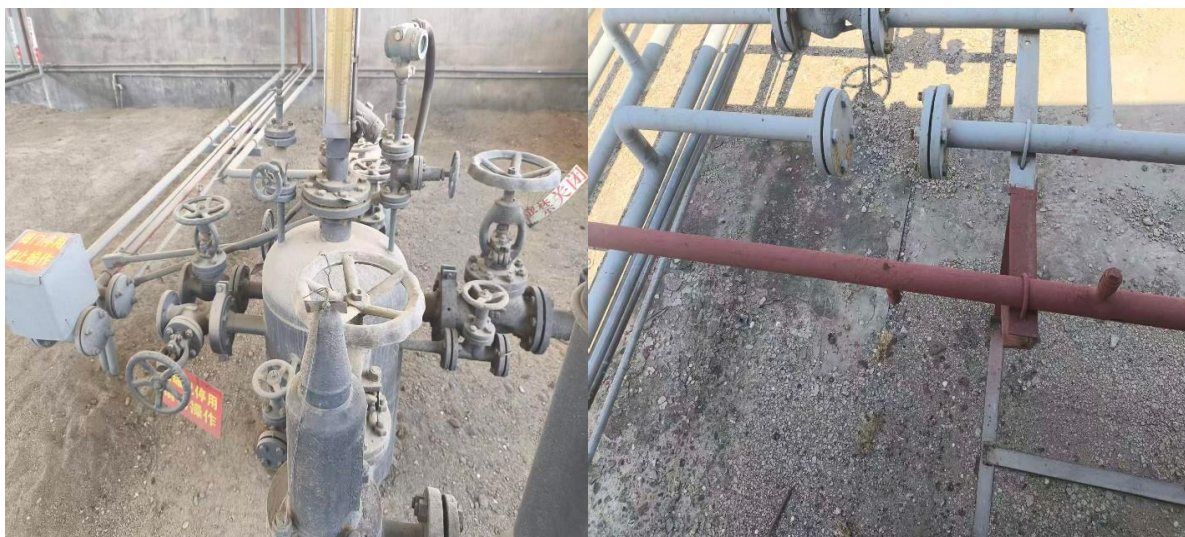
图3-11 3#储罐物理隔离图
